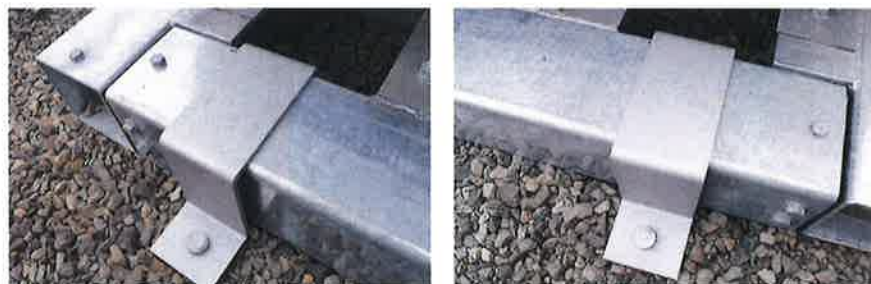
ズレ止め金具の設置
